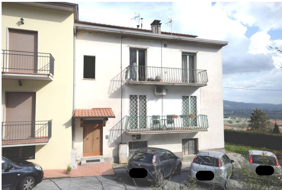
Vista del fabbricato lato da Strada Tuderte
