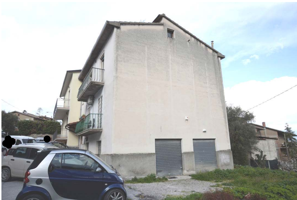
Vista lato sud - ingresso magazzino
