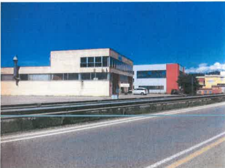
Foto n. 5 – Vista fabbricati industriali limitrofi
