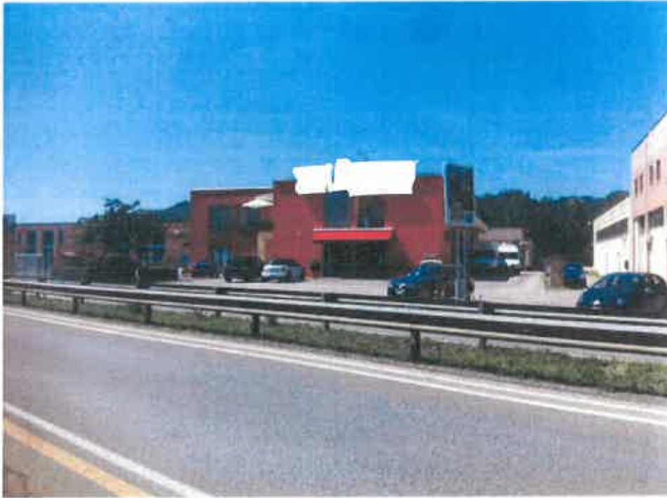
Foto n. 4 – Vista fabbricati industriali limitrofi
