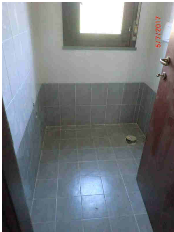
Fotografia n. 10 – Bagno zona giorno
