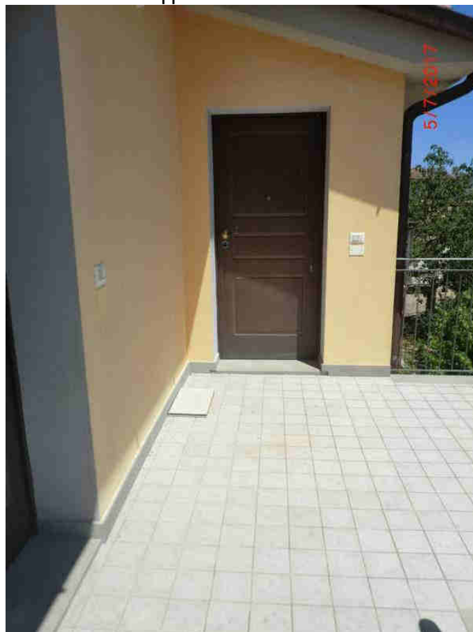
Fotografia n. 4 – Portone di accesso
