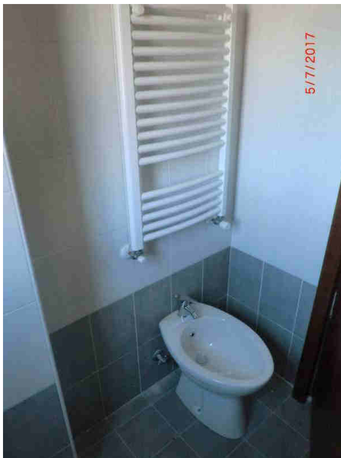
Fotografia n. 11 – Bagno zona giorno
